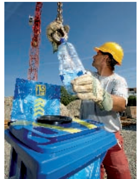
Neu sammeln über 600 Bauunternehmen auch PET-Flaschen.
